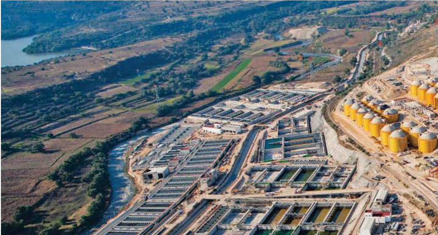
Planta de Tratamiento de Aguas Residuales Atotonilco (la más grande del mundo en su tipo), Hidalgo.
