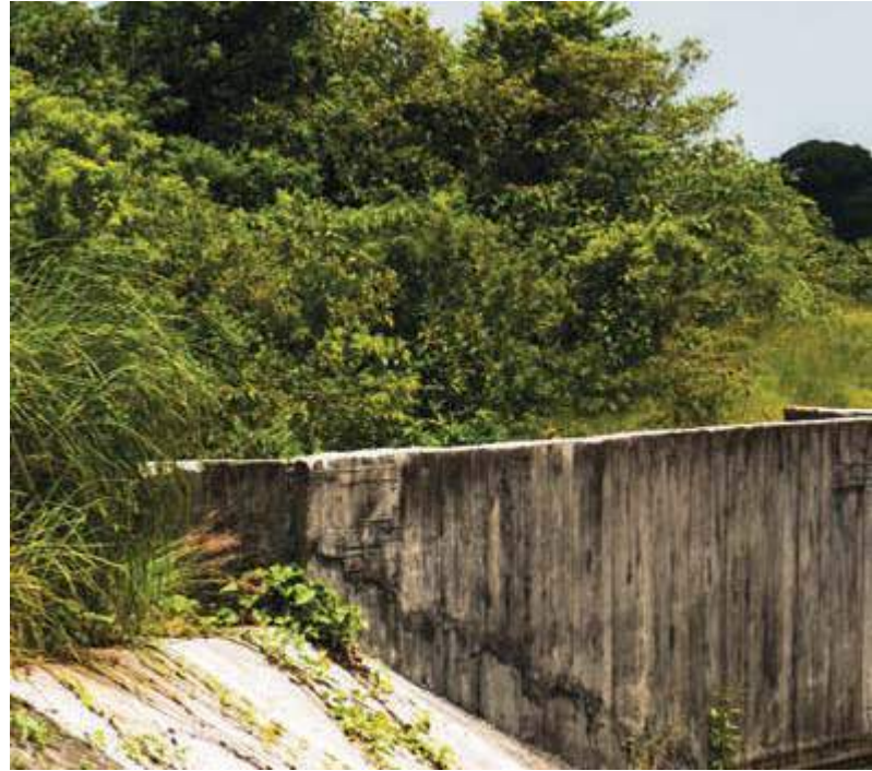
Canal de conducción de la Presa La Cangrejera, Veracruz.
