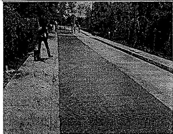
Pavimentación de calles a base de concreto hidráulico
