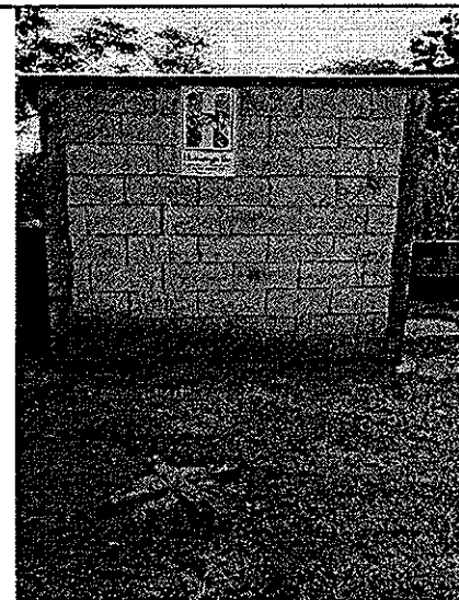
Construcción de Baños Completos con biodigestor de 600 lts.
