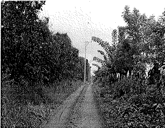
Mejora de Red de Distribución en Media y Baja Tensión
