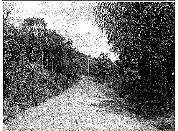
Rehabilitación de camino a base de grava de revestimiento de 1 ½ a fino
