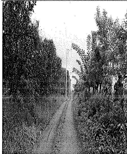
Mejora de red de energía eléctrica en media y baja tensión
